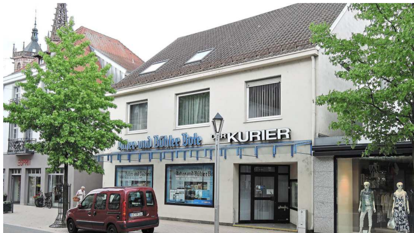
Ein Stück Stadtgeschichte: Nach dem Zweiten Weltkrieg wurde das Gasthaus Hirschen zu einer Geschäftsstelle mit großen Schaufenstern und barrierefreiem Eingang umgebaut. Es entsprach damit dem Zeitgeist.
