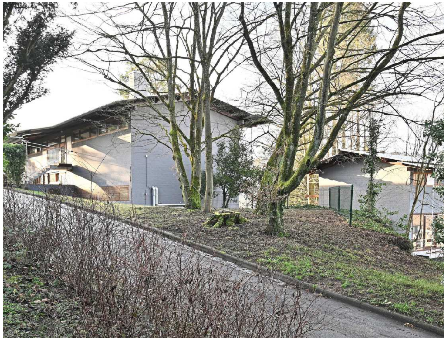
Wirkt wie ein Bungalow: Die Fassade des Villa Eiermann an der Straße Krippenhof ist langgestreckt und wenig spektakulär. Rechts ist das tiefer gelegene Atelierhaus zu sehen. Foto: Ulrich Coenen
