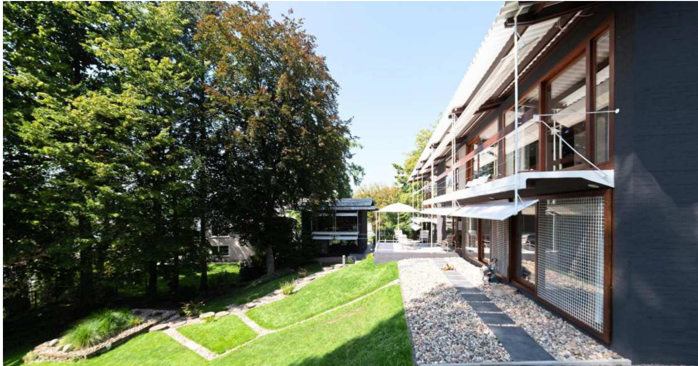
Bilden eine zweite Haut: Vor die Gartenseite der Villa Eiermann treten Balkone und Sonnensegel. Das Welleternitdach ohne Dachrinne steht weit über.
