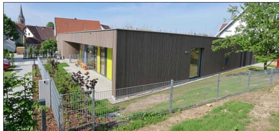
Gutes Beispiel: Der Kindergarten Regenbogen in Baden-Baden-Steinbach entstand nach Plänen von HansUlrich Benz. Auf dem Dach blüht Klatschmohn. Foto: Coenen
