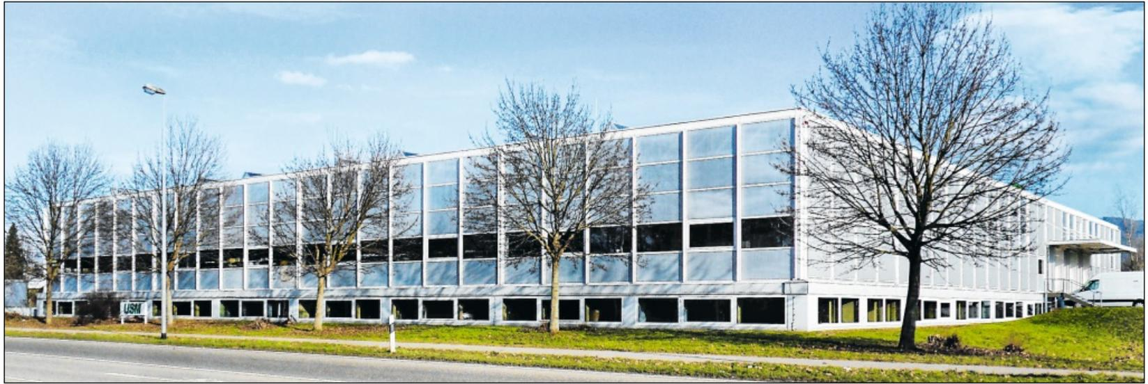
*DIE DEUTSCHE USM-ZENTRALE IN BÜHL entstand ab 1983 in dem von Fritz Haller entwickelten Stahlbau-System Maxi. Dort werden die USM-Möbel für den deutschen Markt montiert. Wegen der besseren Sichtbarkeit wurde das Gebäude im Winterhalbjahr aufgenommen.*
