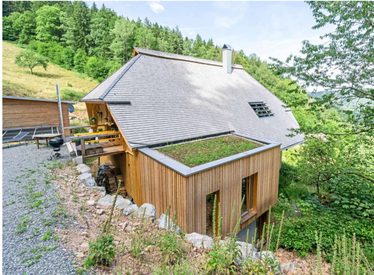
Ein kleiner Stall an der Langseite wurde durch einen zweigeschossigen Anbau mit zwei Räumen ersetzt. Dadurch erhält die Familie moderne Wohnqualität. Foto: Ulrich Coenen
