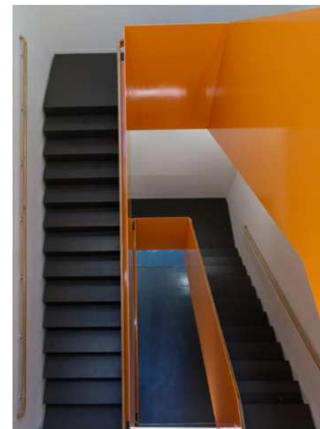
Die Treppenhäuser sind in unterschiedlichen Farben gehalten. Foto: Ulrich Coenen
