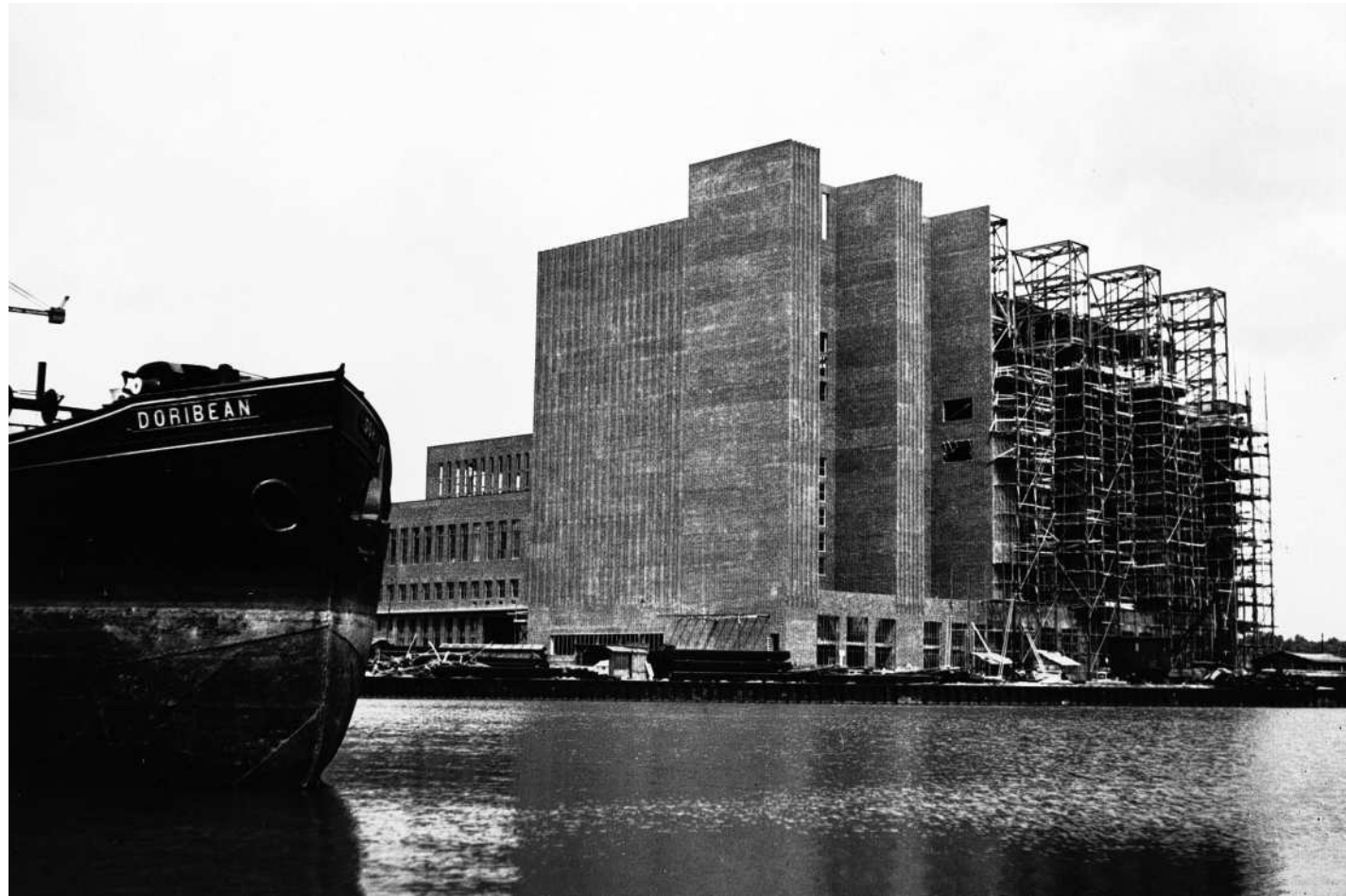
Prestigeobjekt des NS-Staates: Das Foto entstand während der Bauarbeiten des Volkswagenwerks im Jahr 1938. Es zeigt das Kraftwerk Süd und im Vordergrund ein Schiff auf dem Mittellandkanal. Foto: Archiv Volkswagen Aktiengesellschaft
