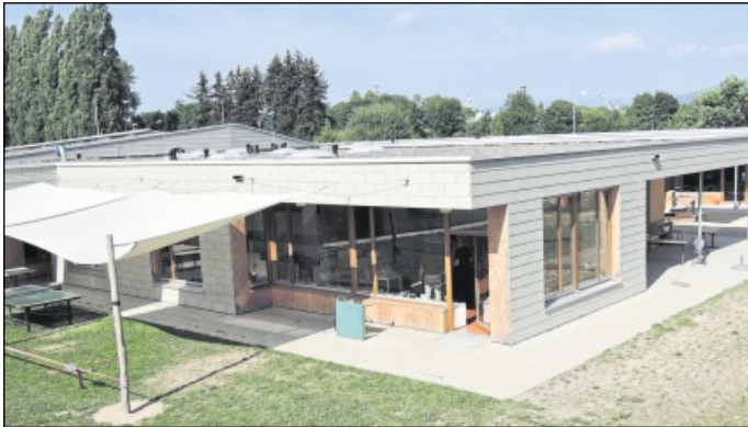
GRAUE FASERZEMENTPLATTEN UND HOLZ prägen die äußere Hülle des Montessori-Zentrums in Offenburg.
