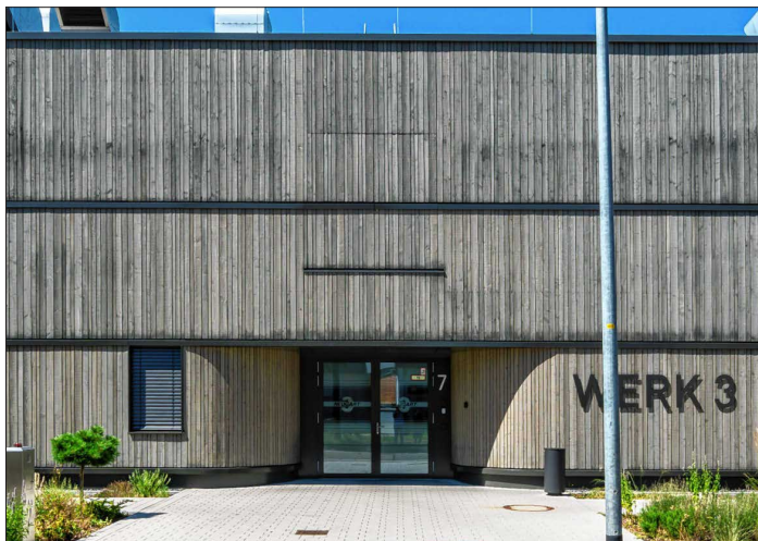
Der Haupteingang ist tief in die Wand geschnitten und dient zugleich als Witterungsschutz.
