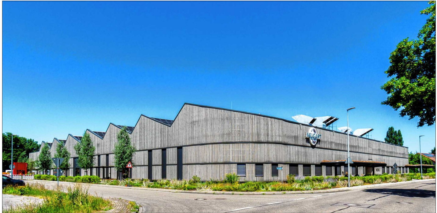
Die abgerundeten Ecken des neuen Werks 3 der Firma Neugart in Kippenheim erinnern an die Stromlinien-Moderne der 1920er- und 1930er-Jahre. Die Fassade besteht aus regionalem Lärchenholz.
