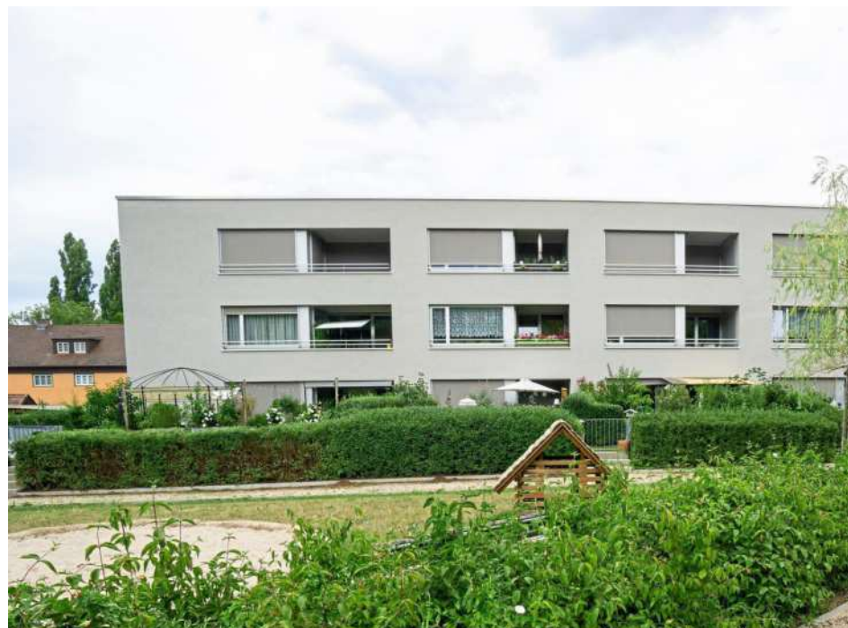
Die moderne Wohnanlage und die Wohnanlage von Paul Schmitthenner aus den 1920er Jahren (hinten links) verfolgen dasselbe Ziel. Es geht um preiswerten Wohnraum mit einer guten Qualität. Foto: Ulrich Coenen
