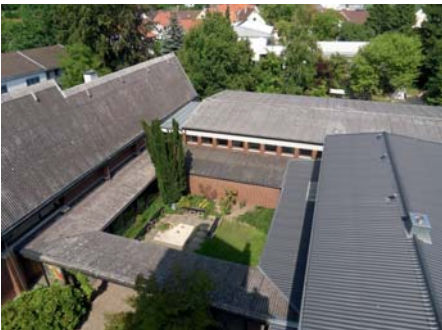
Oben: Johanneskirche und Gemeindezentrum in Bühl (Gesamtansicht von Südwesten).
