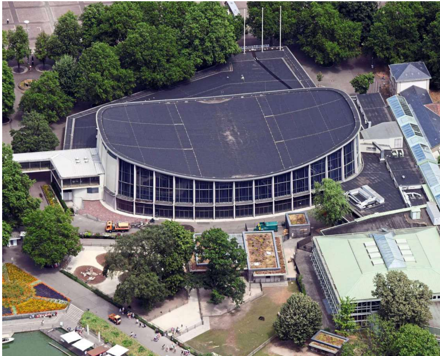
Die Schwarzwaldhalle in Karlsruhe ist eines der Hauptwerke von Erich Schelling. Die 1953 eröffnete Halle besitzt ein selbst tragendes Hängedach aus Spannbeton. Es war das Erste in Europa. Foto: Artis/Uli Deck
