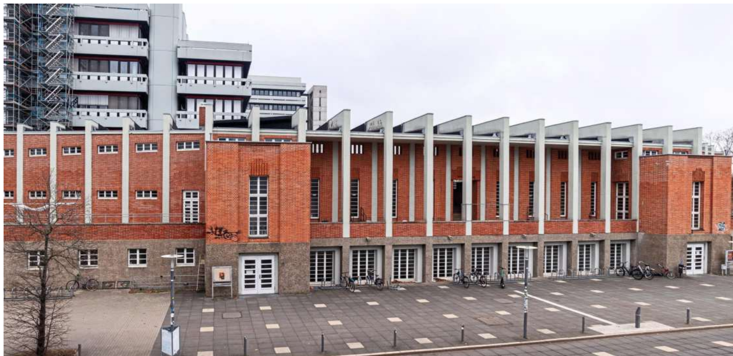
Das Hochschulstadion in Karlsruhe ist ein Werk von Hermann Alker. Erich Schelling war als Mitarbeiter seines Büros maßgeblich an dem Projekt beteiligt. Foto: Ulrich Coenen
