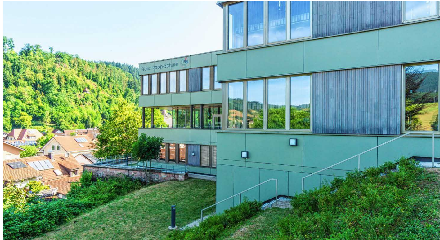
Talseitig steht der Neubau über einer steil abfallenden Wiese hoch über der Stadt. Eine Sandsteinmauer stützt den Hang.
