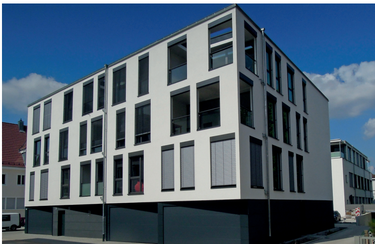
Auf dem Parkplatz des Druckereigebäudes der Konkordia entstand ein Mehrfamilienhaus nach Plänen von Planum, das 2014 fertiggestellt wurde.
