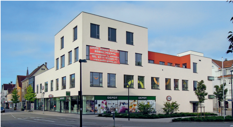
Das „Nordtor“ wurde von der SEPA Projekt- und Entwicklungsgesellschaft (Stuttgart) in den Jahren 2013 und 2014 gebaut.
