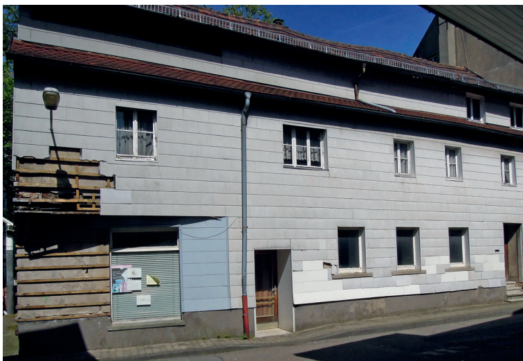
Die ehemalige Gerberei Kuen vor dem Beginn der Sanierung im Frühjahr 2015. Das Foto zeigt die mit Eternitplatten verkleidete Fassade in der Wiedigstraße.
