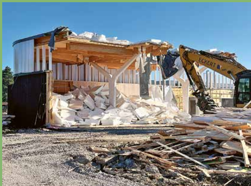
Abriss der Ausstellungshalle, Foto: Ludloff Ludloff Architekten
