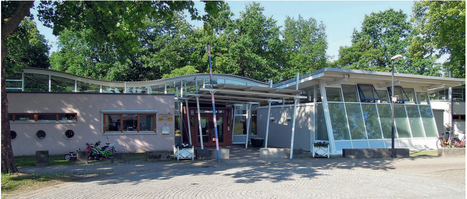
Bühler Kinderhaus: Haupteingang an der Rotkreuzstraße.
