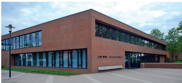
Carl-Netter-Realschule: Ansicht von der Güterstraße.
