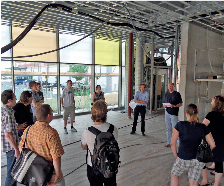
Sporthalle: Architekturstudenten des Karlsruher Instituts für Technologie (KIT) unternehmen im Sommersemester 2011 unter der Leitung ihres Dozenten Ulrich Coenen (Dritter von rechts) eine Exkursion zur Baustelle. Links neben Coenen: Architekt Andreas Löwen-eck. (Foto: Jörg Seiler)
