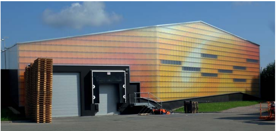
Bada-Gebäude: Eine Lagerhalle wurde im Rahmen eines zweiten Bauabschnitts 2010 an das Verwaltungs- und Produktionsgebäude angebaut.
