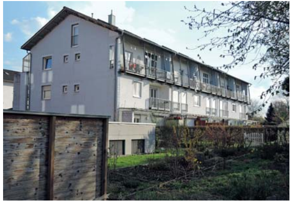
Mehrfamilienhaus (Freiburger Str. 2a und b): Gartenseite.
