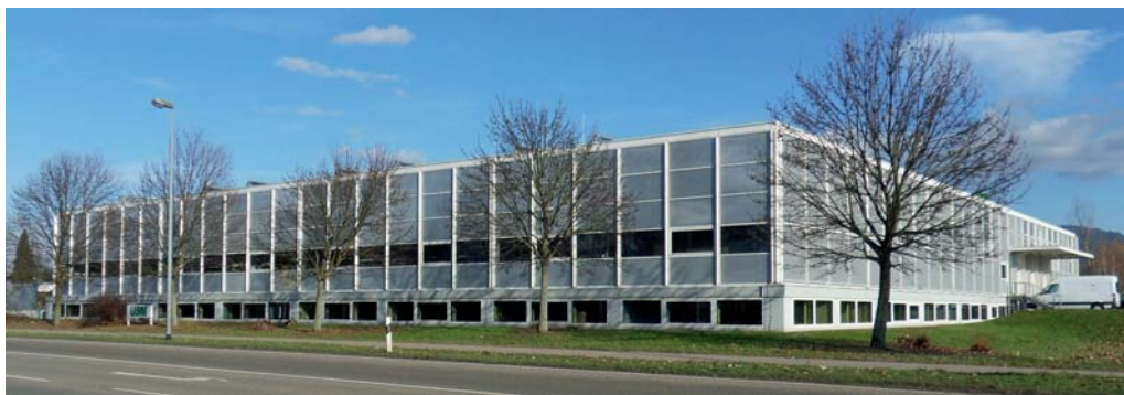
Das USM-Gebäude entstand im Stahlbausystem Maxi von Fritz Haller. Es ist seit Januar 2017 Bühls jüngstes Kulturdenkmal.
