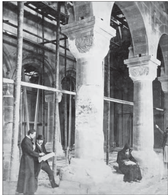
Eine wesentliche Idee, die den einzigartigen Fotografien von Lohmüller zu Eigen ist, ist die Inszenierung der Bilder mit Personen. Auf dieser Fotografie ist es ein Vertreter der Bauleitung, ein Vikar und ein Mönch. Gut zu erkennen sind die umfassend erfolgten Sanierungsarbeiten an den Kapitellen. Um 1893. Foto: Stadtgeschichtliches Institut Buhl
